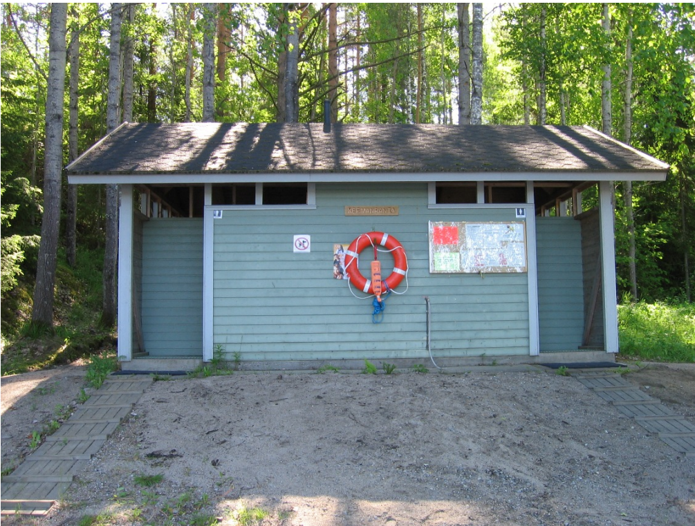
Kuva 9. WC:t ja pukukopit samassa rakennuksessa. Seinällä myös pelastusrenkas ja ilmoitustaulu.
