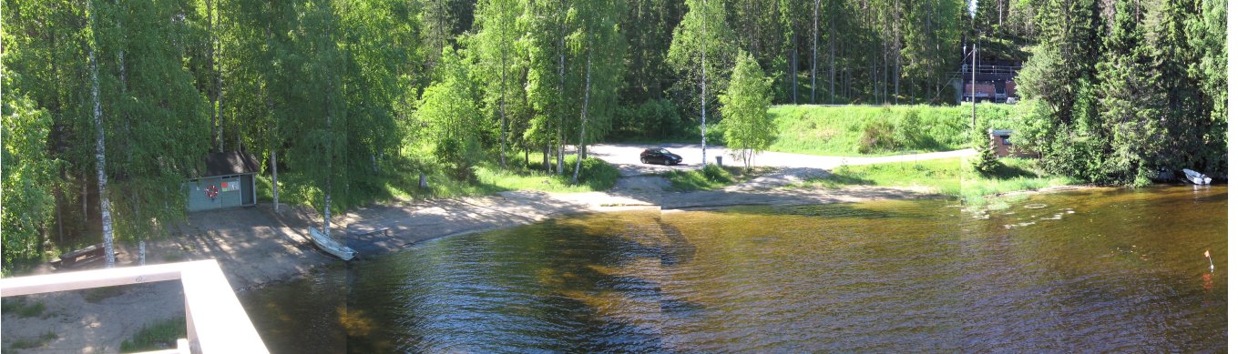
Kuva 6. Kermanranta hyppytornista katsottuna. Vasemmalla pukukopit ja pelastusvene. Oikeassa reunassa näkyvä pieni tiilirakennus on rantapumppaamo ja sen takana hieman isompi tiilirakennus on Kermanrannan pintavesilaitos.
